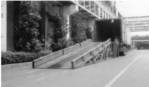
載貨台裝卸貨物其高差在一·五公尺時，已提供勞工安全上下之設備
