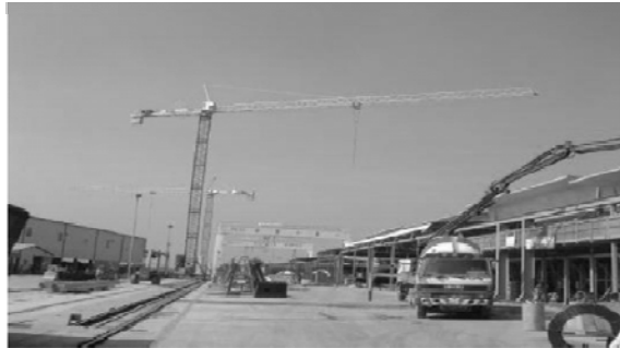
圖一 固定式起重機
